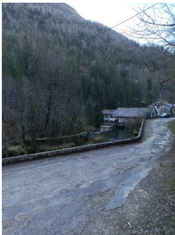
Figure 4 : Vue de la prise d'eau actuelle, depuis la parcelle AL0009
