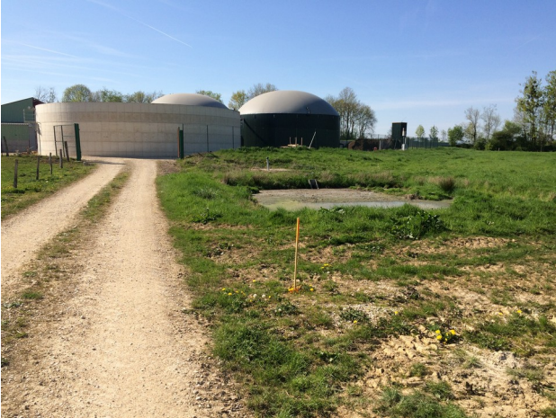
1 Vue depuis l'angle sud-est du site
