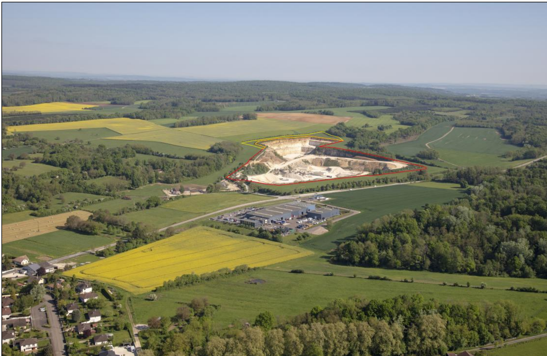
Photographie 4 : Vue lointaine du projet - depuis le Sud
