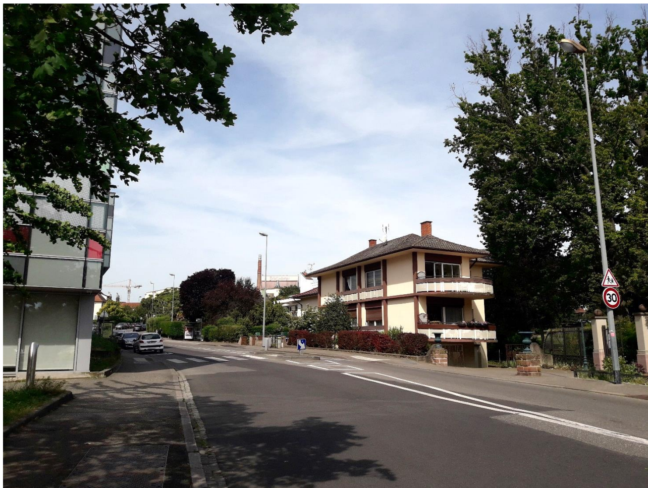
Photographie 21 : Vue de loin sur la cheminée du site d'étude depuis la Rue Louis Pasteur (abords est du site d'étude)
