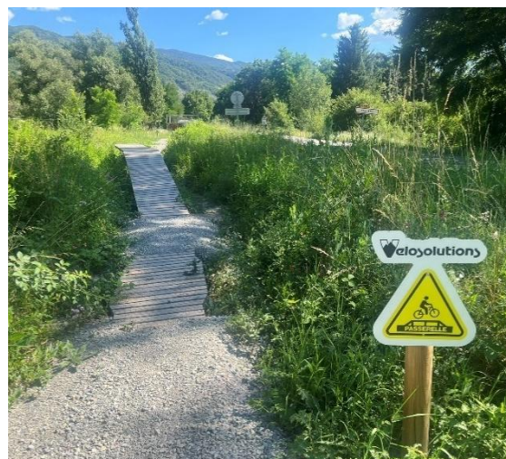
Référence d'intervention pour l'aménagement de la piste ludique VTT : bande de roulement en empierrement, modules en bois et signalétique bois Source : Alpicité 2024
