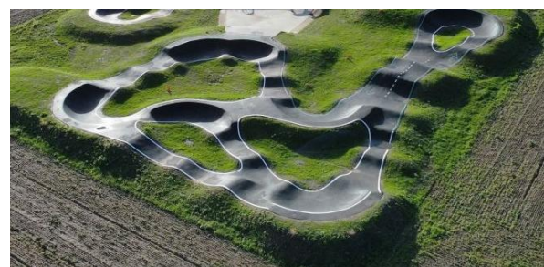
Référence d'intervention pour l'aménagement d'un pump-track : pistes en enrobé noir avec tracés blancs, remblais végétalisés Source : CG Concept
