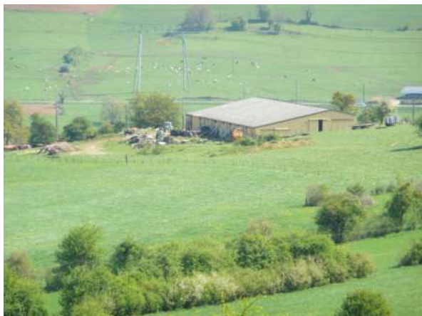
Site d'exploitation à l'écart du village
