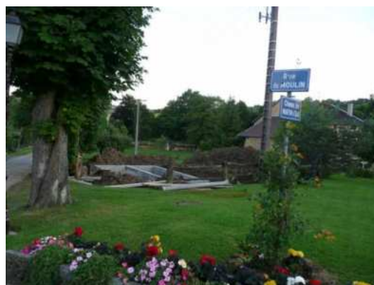
Travaux de mise en place de la citerne
