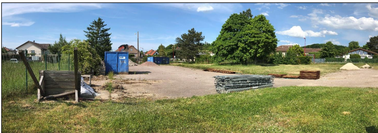
Photo 14 : Zone imperméabilisée (Source : BE-JC, 19/05/2025)
