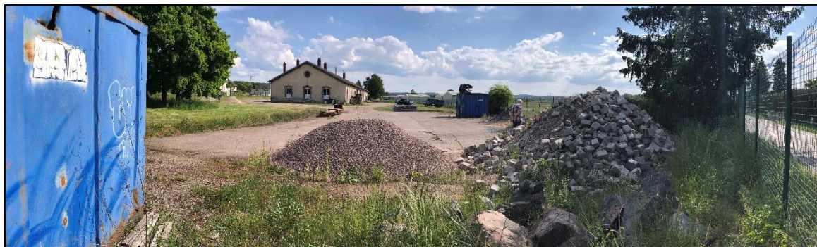
Photo 15 : Dépôt de matériaux (Source : BE-JC, 19/05/2025)
