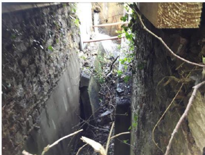
Ci-contre : Vues sur le Pertuis de fond et les dispositifs de confortement
