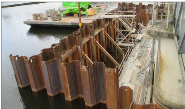
Figure 36 : Dispositifs de mise à sec envisagés
