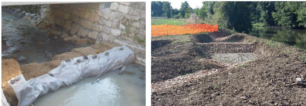
Figure 38 : Exemple de dispositifs de filtration des MES intra cours d'eau (photo de gauche) et en parallèle de la rivière (photo de droite) (source : BURGEAP)
