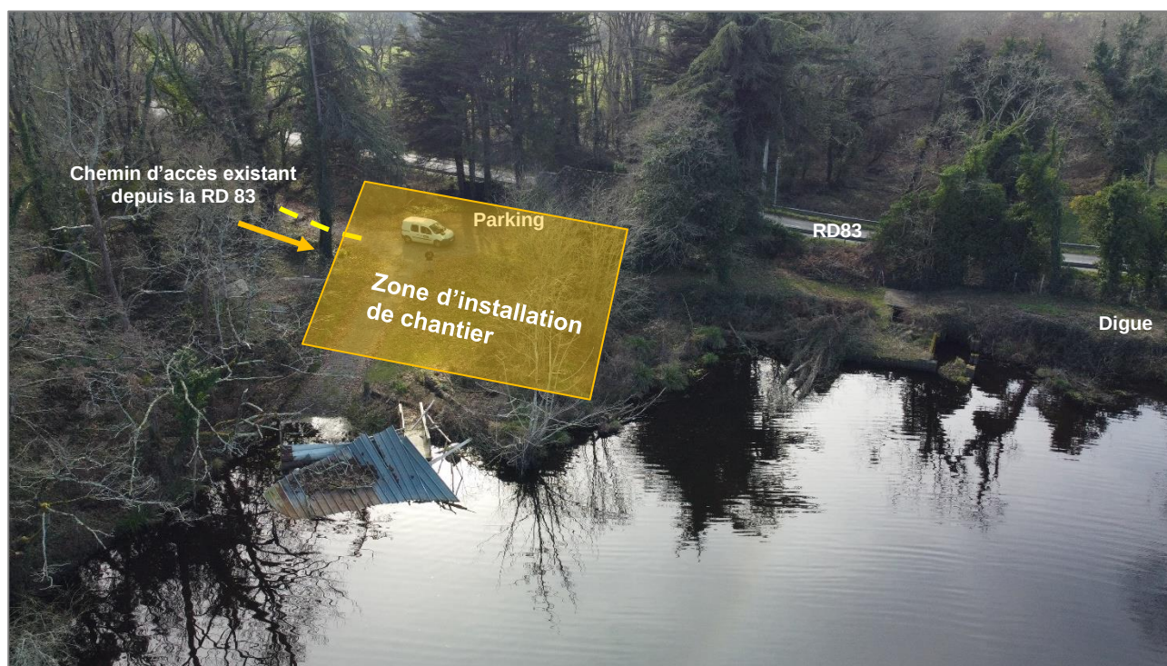
Figure 33 : Accès principal au site depuis la RD83 et parking existant (Photo par drone : Dépt. 44, fév. 2023)
