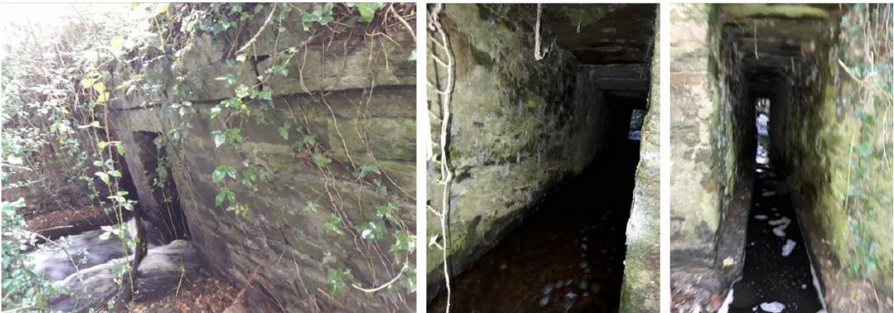
PHOTOGRAPHIE 11 : OUVRAGES cadre de franchissement sous la RD83
