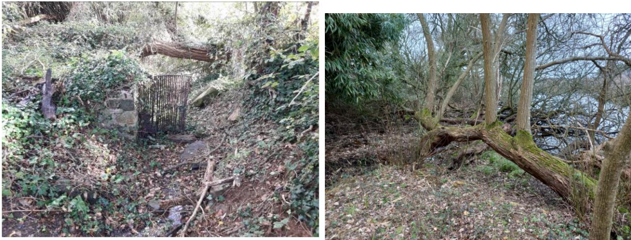
Vue sur la partie amont du fossé de décharge
