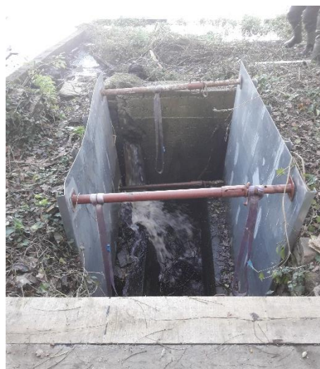
Photographie 4 : Vue sur le puits de fond renforcé par un blindage provisoire
