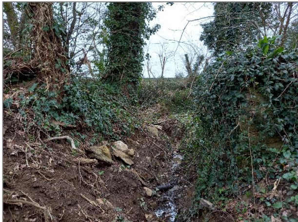
Photographie 12 : Vue depuis l'étang sur le mur à droite de l'ancienne grille - Positionnement du futur seuil
