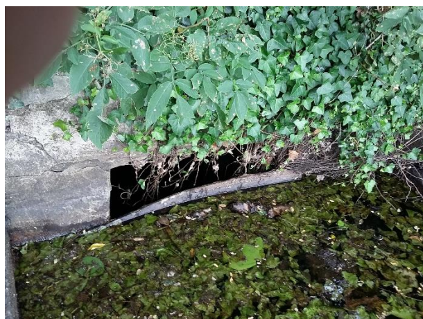
Photographie 1 : Vue sur le puits de demi-fond, côté étang
