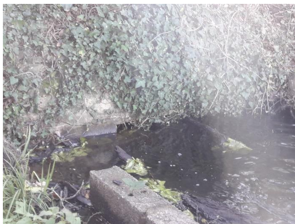
Photographie 3 : Vue sur le puits de demi-fond
