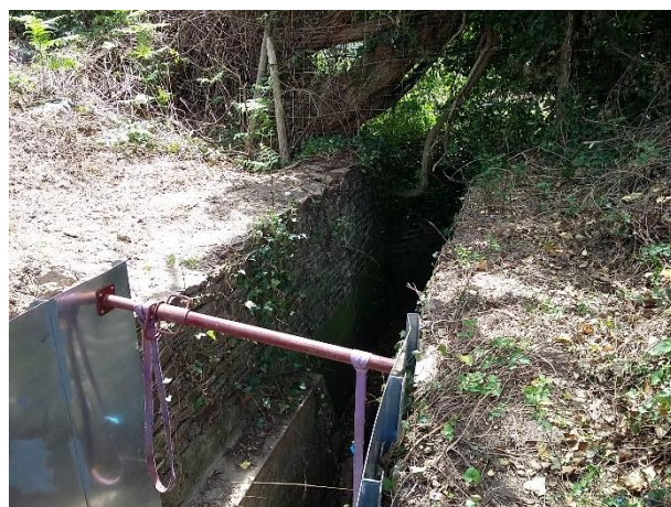
Photographie 2 : Vue sur le puits de fond - côté étang
