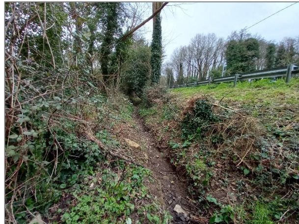
Photographie 13 : Fossé de décharge actuel en bordure de la RD83 – Positionnement de la future rampe
