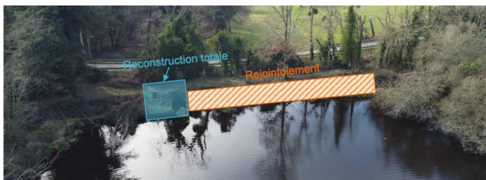
Figure 17 : Travaux de confortement / reconstruction de la digue
