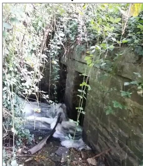
Ouvrages sous la RD83 (côté étang)
