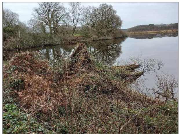
Sujet arraché et tombé dans l'étang devant les ouvrages hydrauliques (photo GINGER BURGEAP, fév. 2023)
