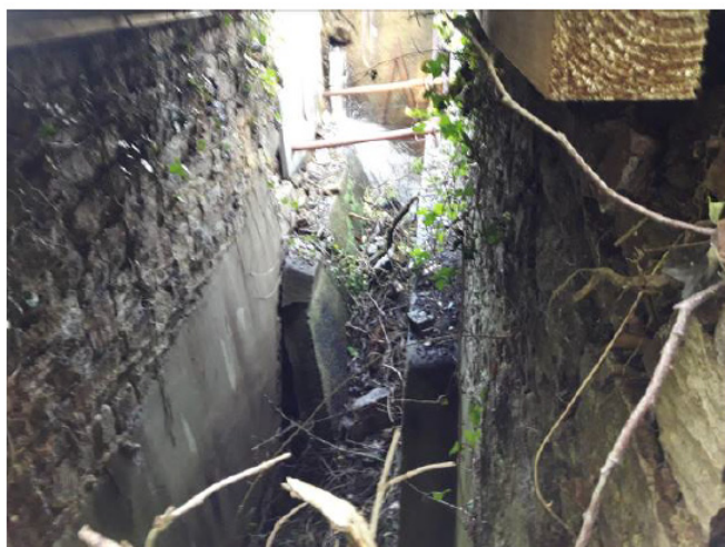
ouvrage sous digue à démolir
