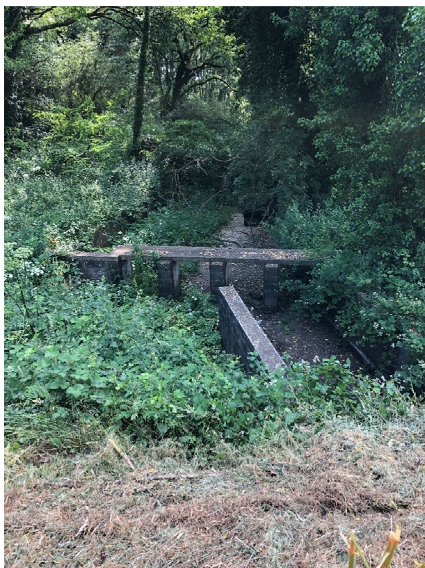
Etier de Foy aval RD83 Ouvrage à démolir
