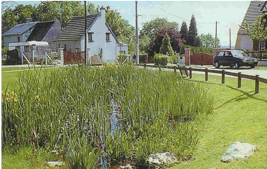
Figure 31 : Exemple d’un bassin de retenue à ciel ouvert
