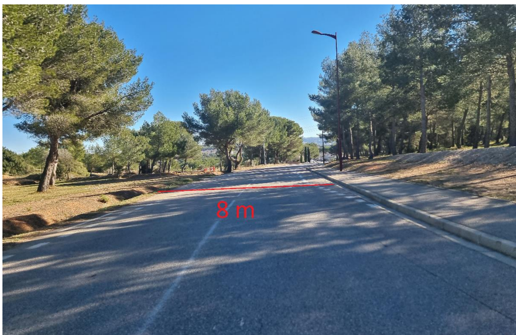
Figure 48 : Chemin des Termes (photo n°1 – source : MTDA)
