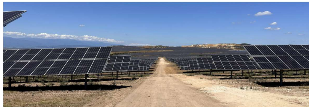
Visuel de l'inclinaison des trackers avec des tables 1 module. (Des tables 2 modules sont envisagés pour notre projet, espacées de 9m)
