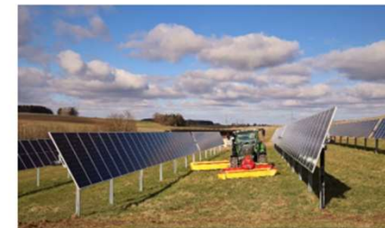
Visuel de l'inclinaison des trackers avec des tables 1 module. (Des tables 2 modules sont envisagés pour notre projet, espacées de 9m)
