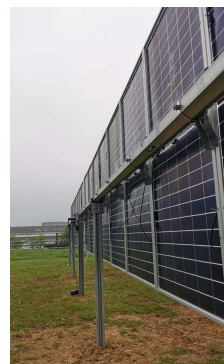
Visuel de l'inclinaison des trackers avec des tables 1 module. (Des tables 2 modules sont envisagés pour notre projet, espacées de 9m)
