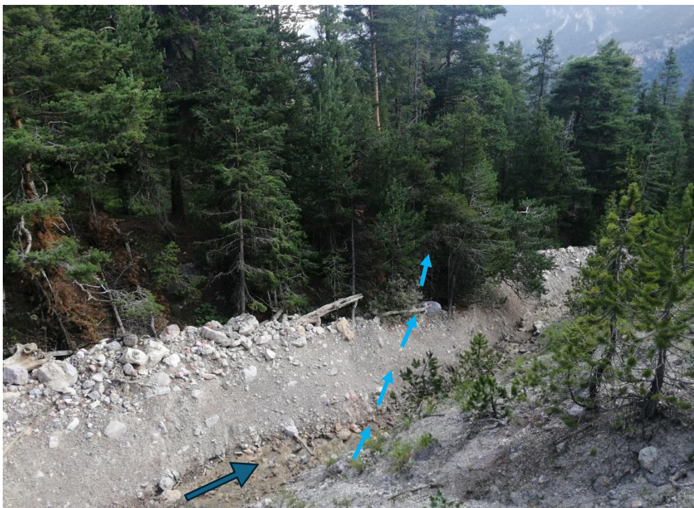
↑ Fig. 2 Vue vers l'aval et la rive gauche du torrent, extrémité amont de la déviation.
