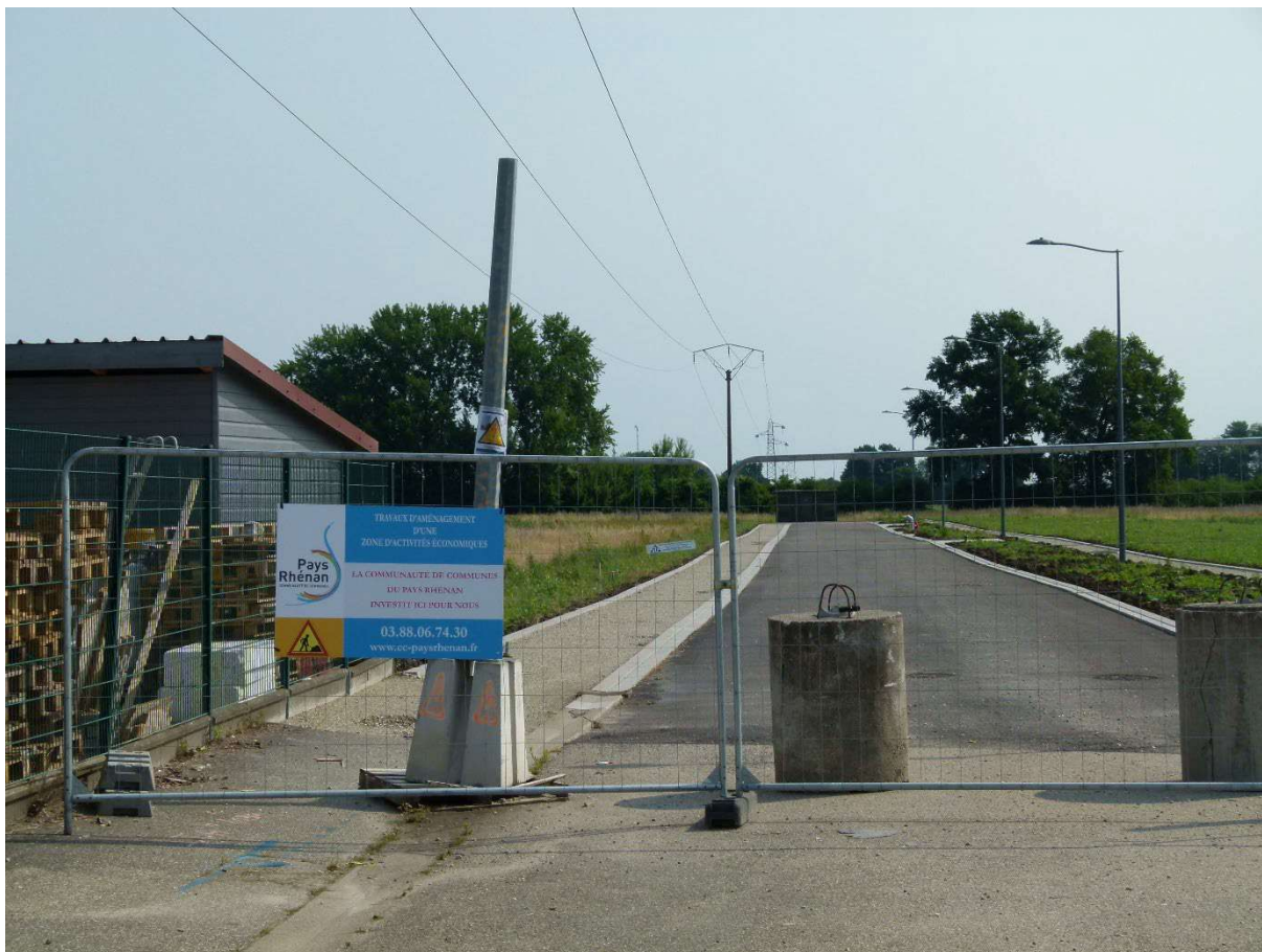
11 – Vue depuis la partie nord de la ZA de Kilstett (Rue Ampère) sur l'ouvrage à déposer et l'extension de la zone d'activité (cliché du 9 juin 2025)
