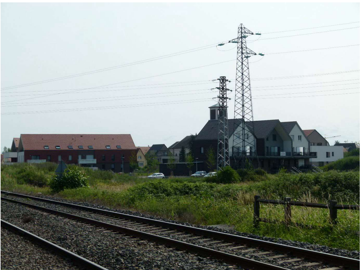
2 – Vue depuis le passage à niveaux « Chemin rural du Viehweg » en direction des extensions urbaines récentes de La Wantzenau : support qui disparaîtra (cliché du 9 juin 2025)
