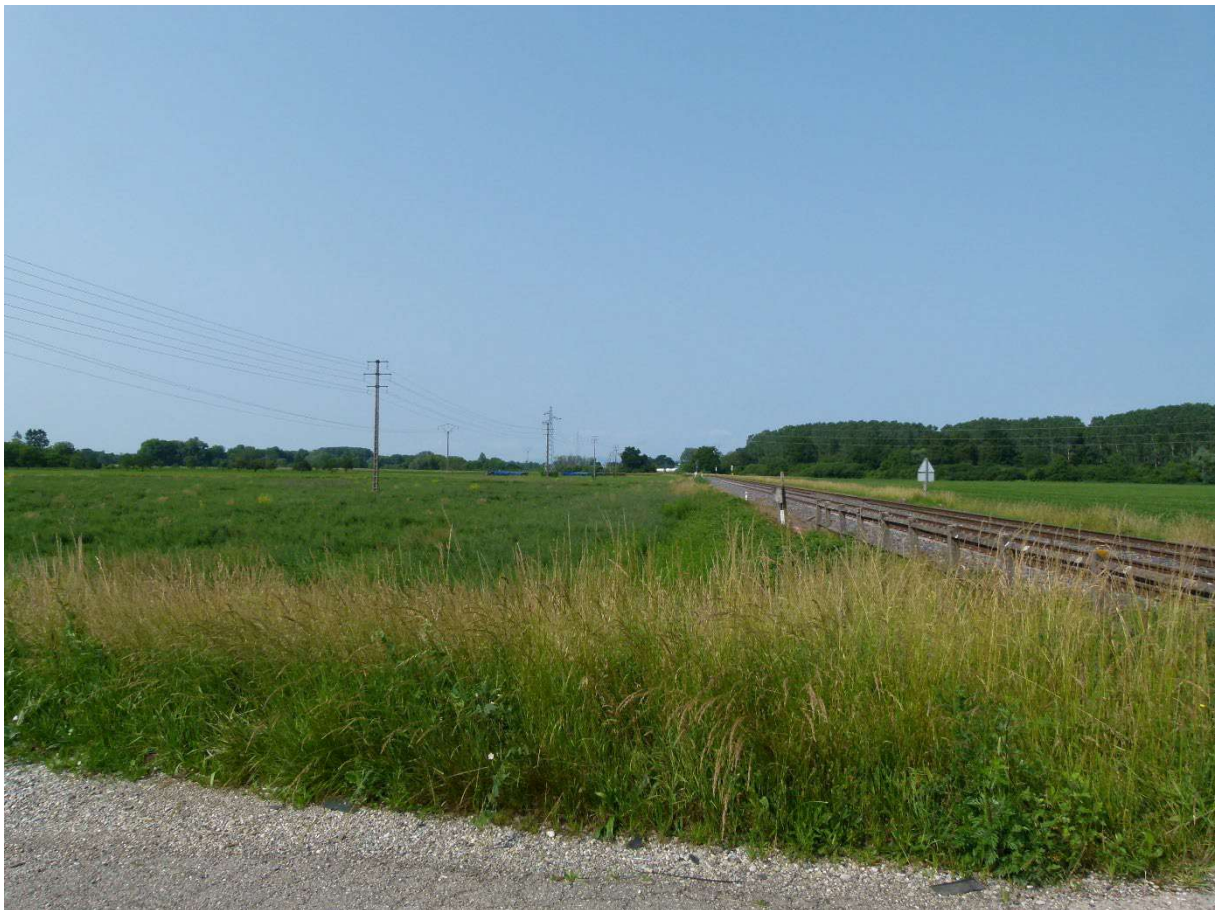
1 – Vue depuis le passage à niveaux « Chemin rural du Viehweg » : le nouvel ouvrage longera la voie ferrée (cliché du 9 juin 2025)
