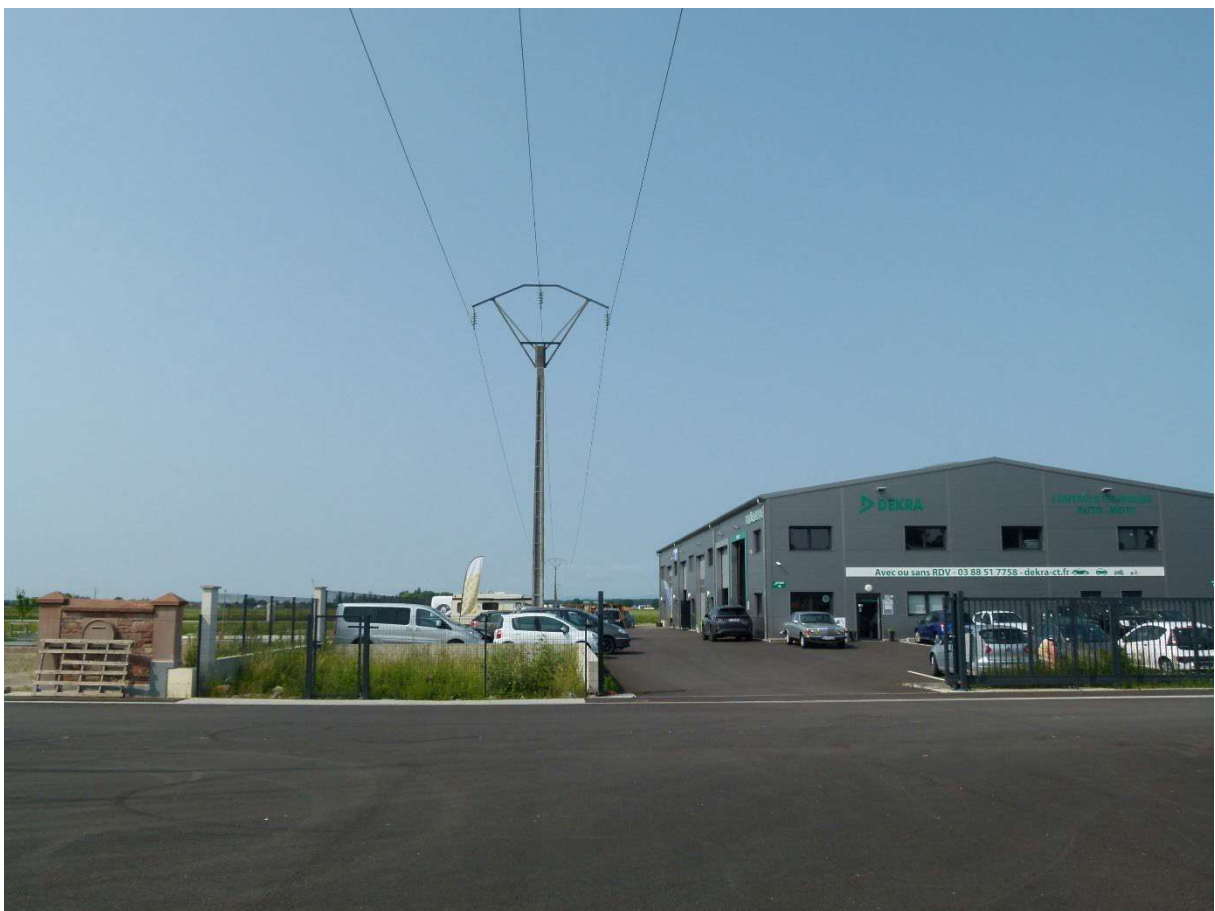
10 – Vue depuis la partie sud de la ZA de Kilstett (rue Eiffel) sur l'ouvrage à déposer (cliché du 9 juin 2025)
