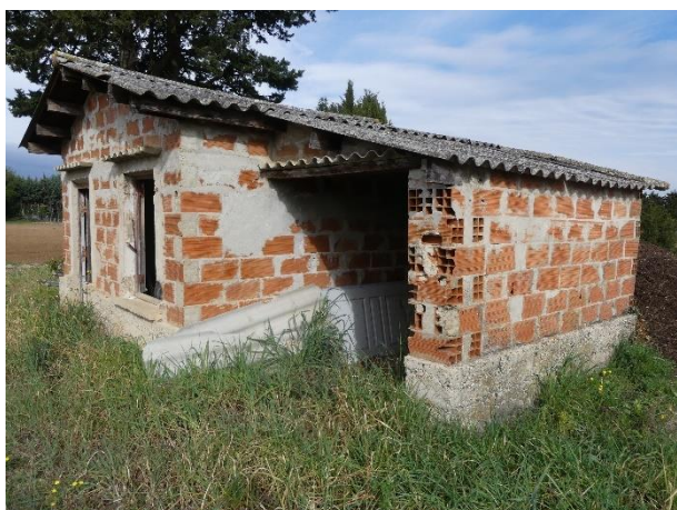
Bâtiment (site Sud)
