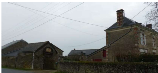
3. Demeure en vis-à-vis avec mur en pierre et caves
