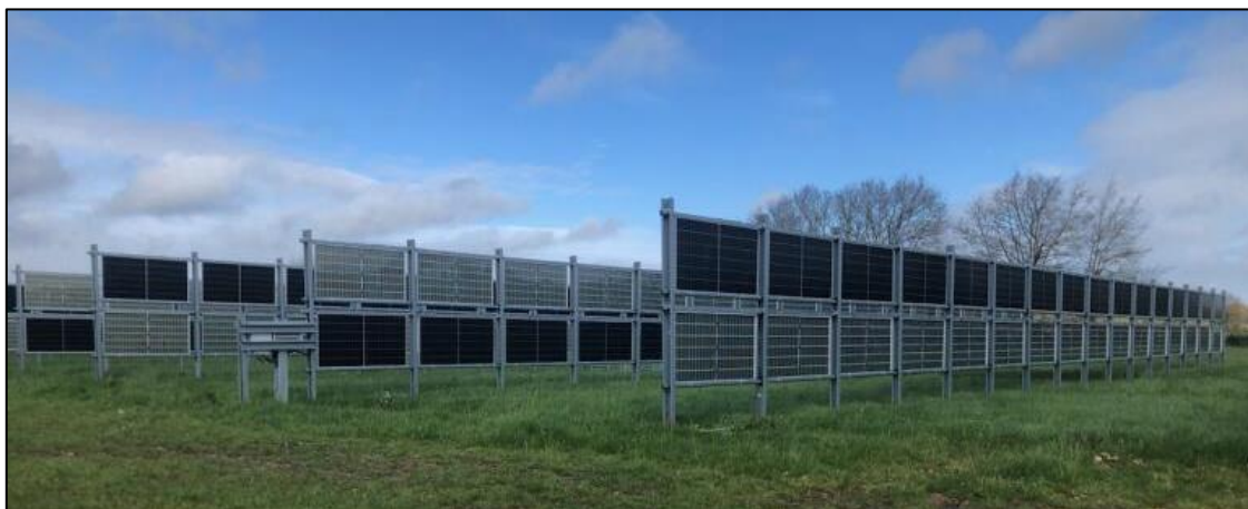
Photographie 1 : Photo de panneaux verticaux – Site pilote de Bressuire (79) mis en service en janvier 2024 (Source : Impulsion)
