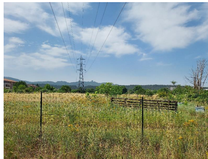
Prise de vue n°6 : Vue en direction du Sud depuis le centre du site – vue sur la friche et zone clôturée, vue sur la ligne électrique haute tension traversant le site (13/06/2025)
