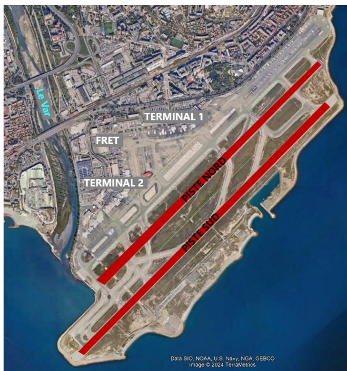
FIGURE 1. VUE AERIENNE DE L'AEROPORT DE NICE ET LOCALISATION DES PRINCIPALES INFRASTRUCTURES.
