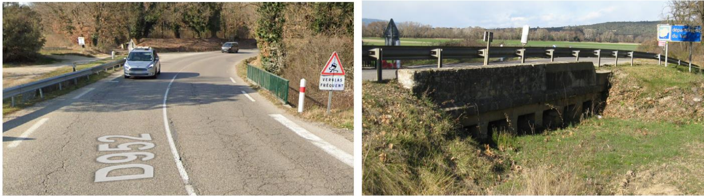
Figure 17 - Photographies de l'ouvrage de franchissement du ruisseau de Boutre par la RD952
