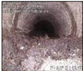
Dépôt de remblais
