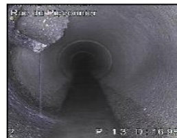
Raccordement défectueux
