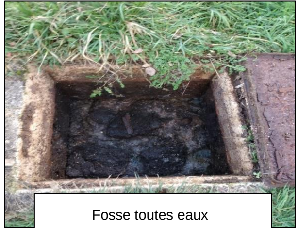
Regard avec une plaque pour stopper les gros effluents (dégrilleur)
