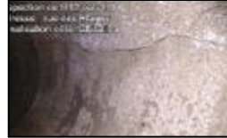
Fissure longitudinale
