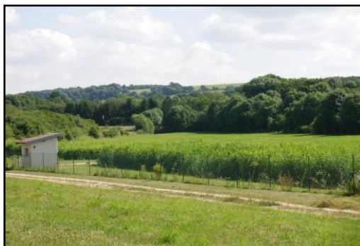
Exemple de station « filtres plantés de roseaux » (commune de Marac – 52)
