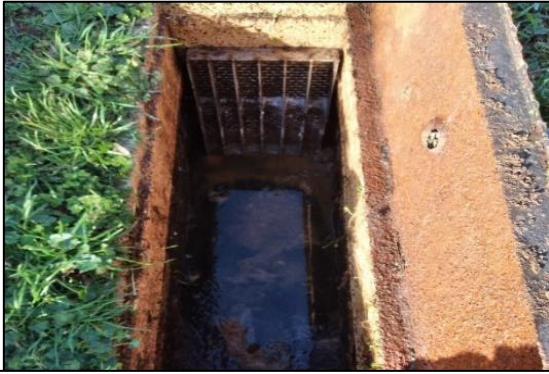
Regard avec une plaque pour stopper les gros effluents (dégrilleur)
