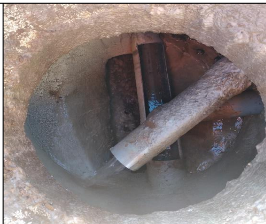
Arrivée des eaux du lavoir
