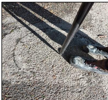
Regard 6 (sous l'enrobé) Rue de la Fontaine
