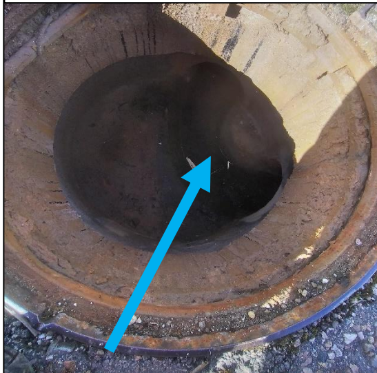
Regard EP (rejet vers fossé infiltrant)
