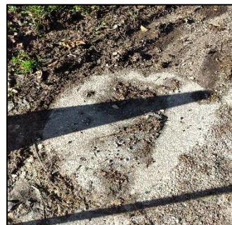
Regard 7 (sous l'enrobé) Rue de la Fontaine
