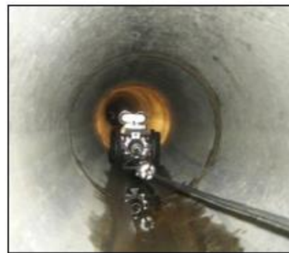
Inspection caméra d'un réseau
