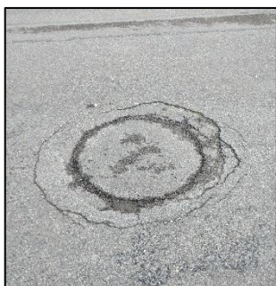
Regard 2 (sous l'enrobé) Rue de la Fontaine
