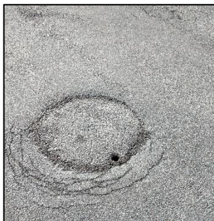
Regard 4 (sous l'enrobé) Rue de la Fontaine
