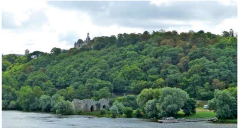
La colline de la citadelle et les moulins pendus vus depuis le pont.
