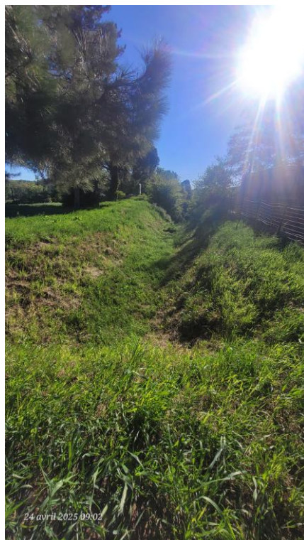
Bassin de rétention (casier 1)
