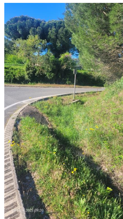
Fossé de la route de Camps (vu vers le carrefour Rte de Camps / Av. de Lattre de Tassigny)
