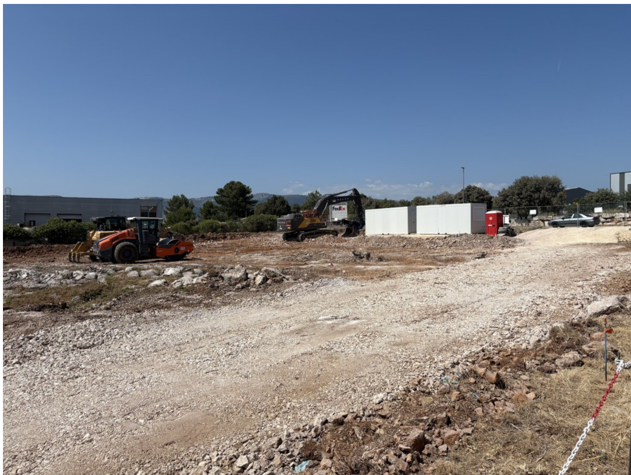
Aperçu de la zone de chantier et de la base vie implantée au Nord de la zone d'étude au niveau de l'Allée de Bruxelles
