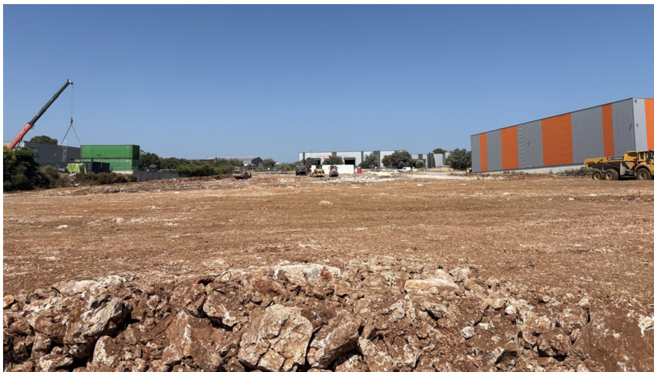
Aperçu de la zone de projet depuis l'extrémité Sud en direction du Nord
