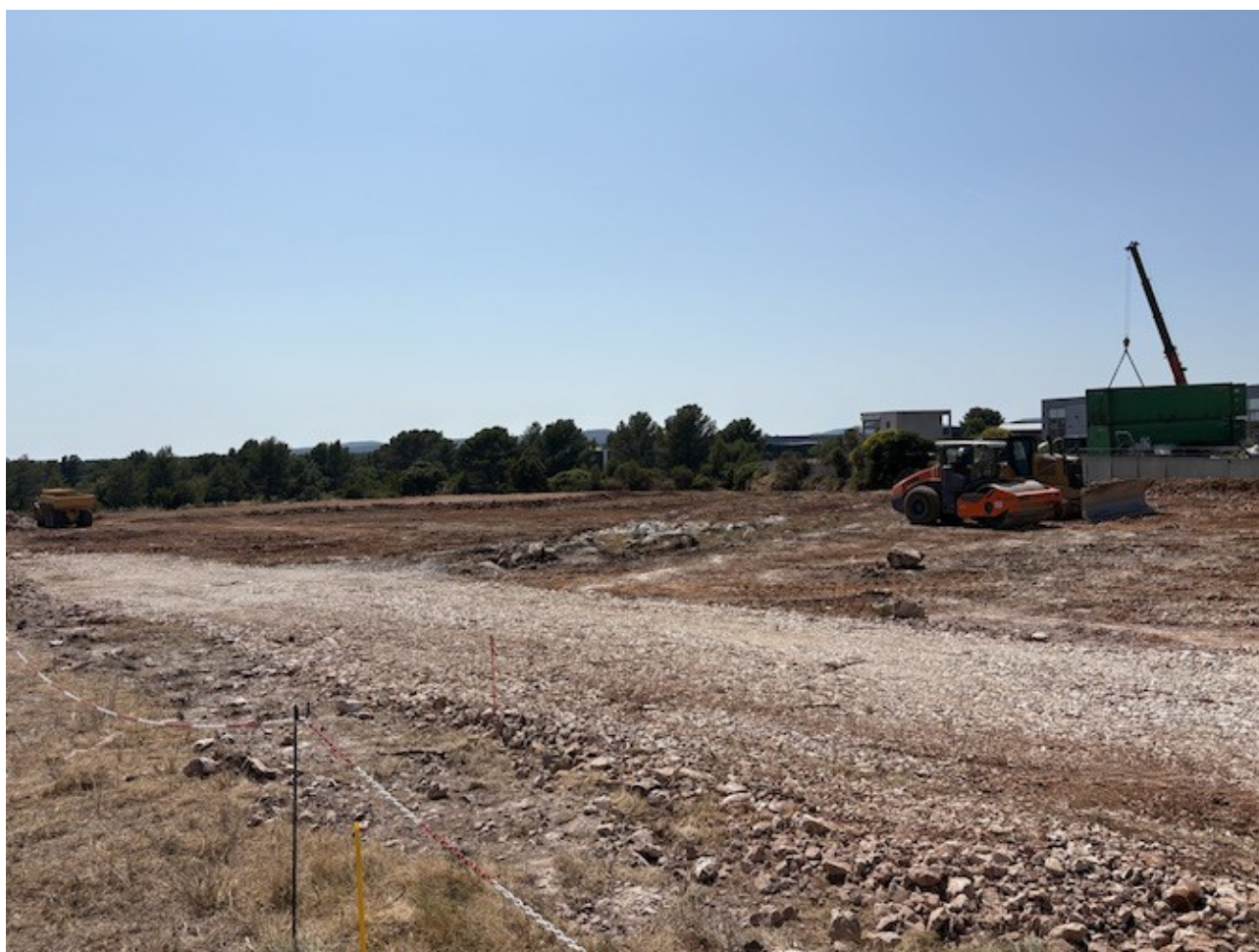
Aperçu de la zone de projet depuis l'extrémité Nord en direction du Sud-Ouest constituée par une zone de travaux et des remblais
