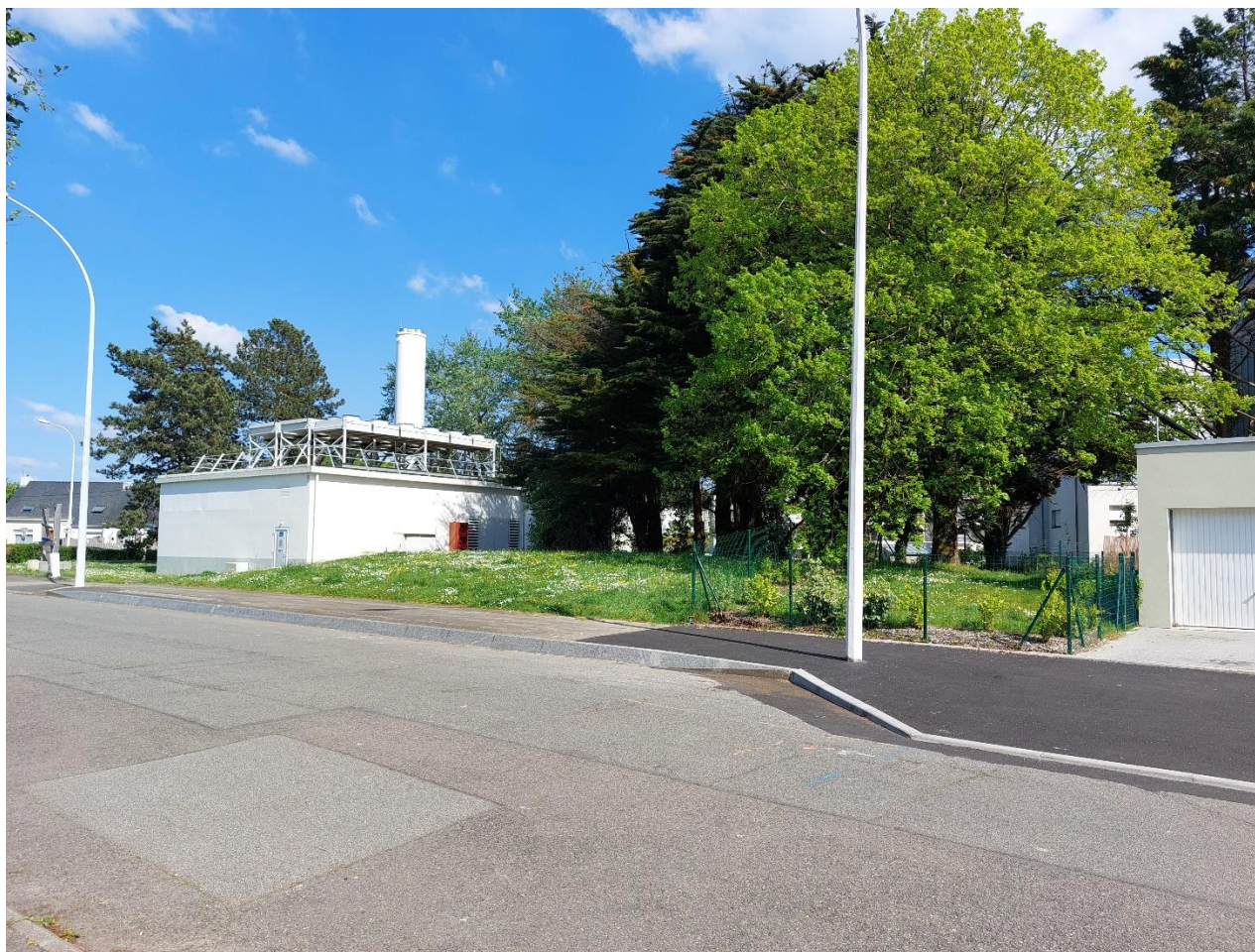
Photo 12 : emplacement de la pompe à chaleur de la chaufferie de La Bouletterie – vue lointaine
