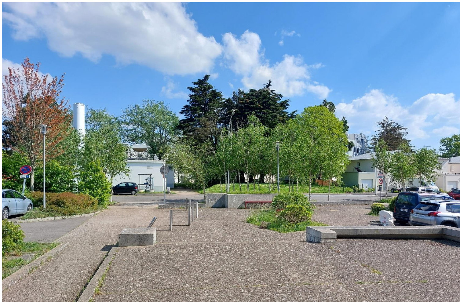
Photo 11 : emplacement de la pompe à chaleur de la chaufferie de La Bouletterie – vue lointaine
