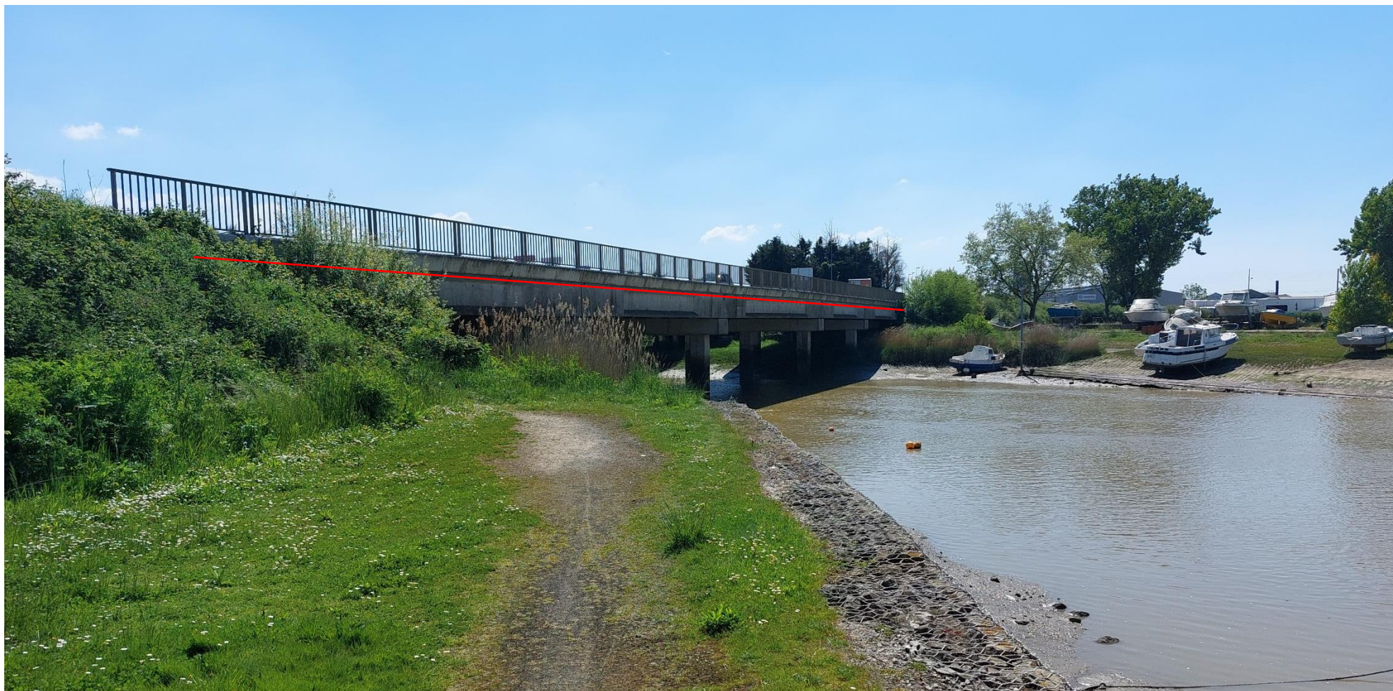
Photo 4 : passage du Brivet en encorbellement sur le pont
