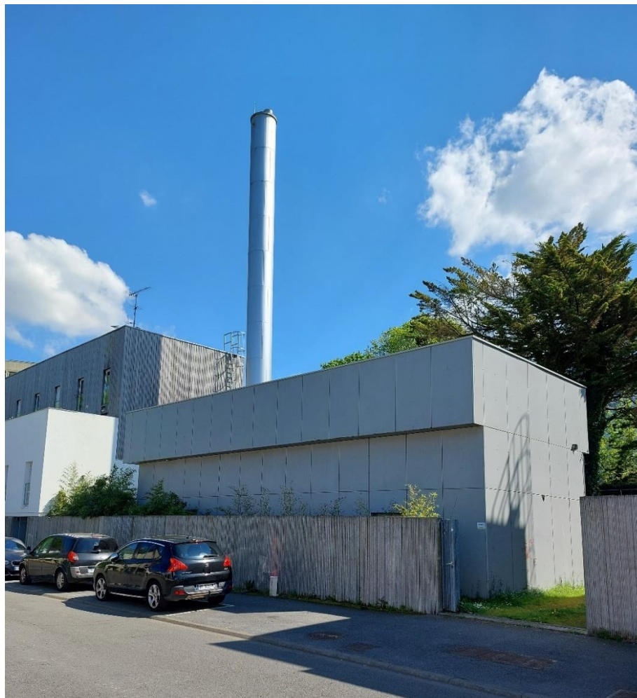
Photo 7 : chaufferie existante de Kerlédé
