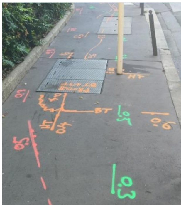
Figure 5 : Exemple d'opération de marquage réalisée
