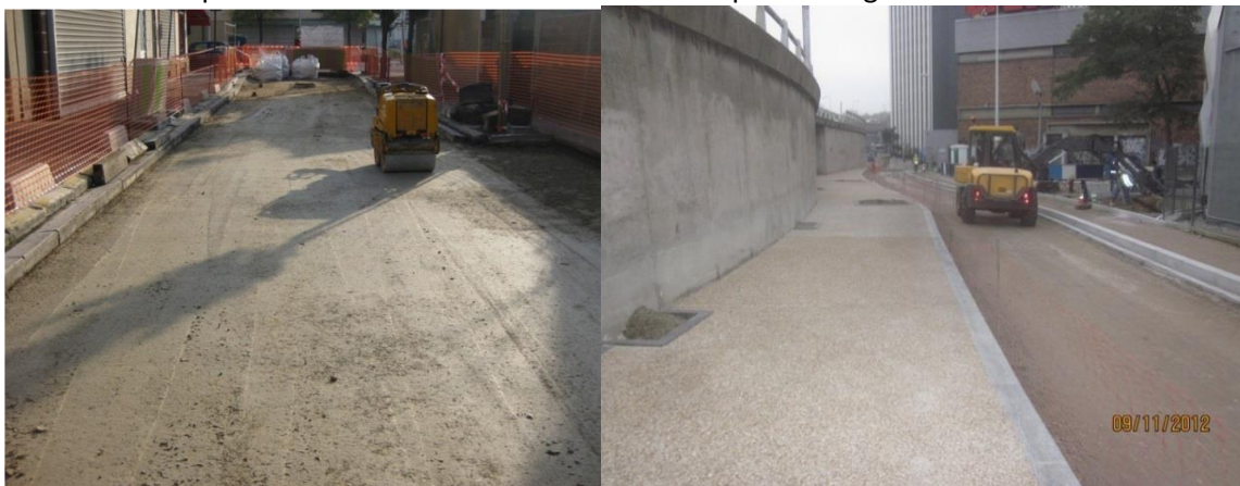
Figure 12 : Exemples de réalisation travaux de réfection de voirie
