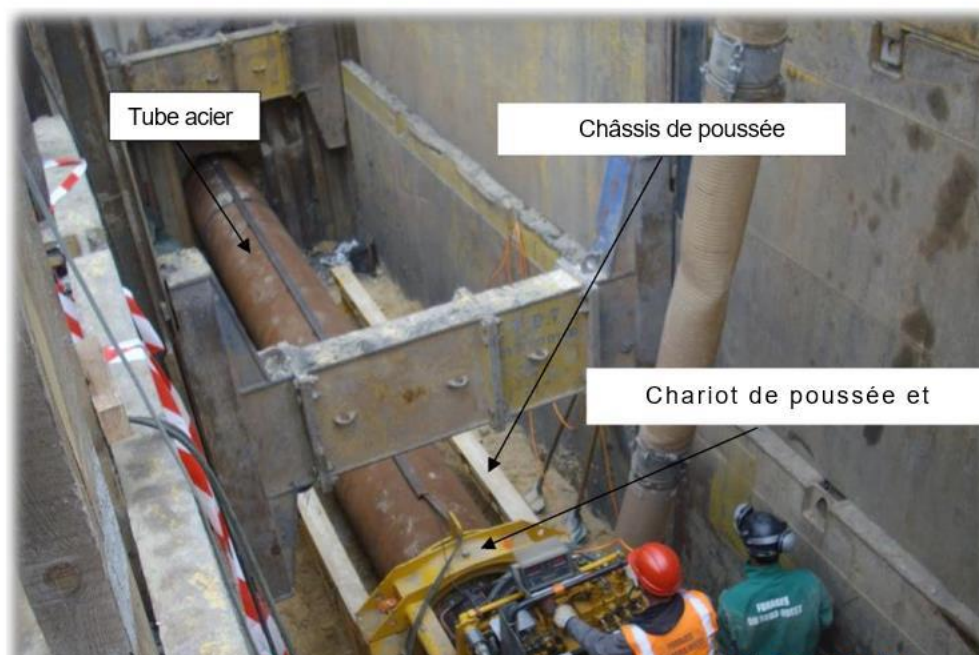
Figure 10 : travaux de fonçage
