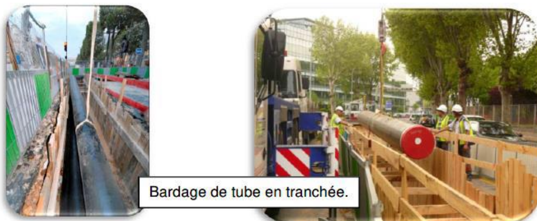
Figure 8 : bardage de tubes en tranchée
