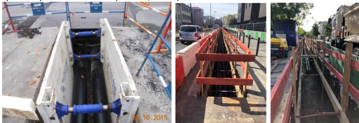
Figure 6 : Exemples de blindage de tranchée
