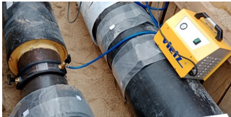
Figure 16 : Exemple de contrôle des soudures
