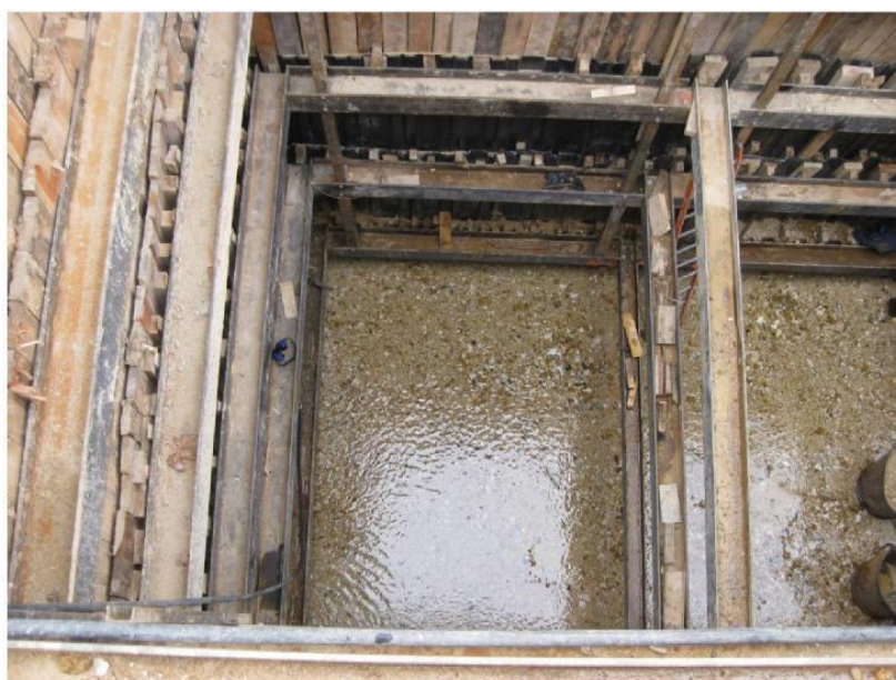
Figure 9 : Puits d'entrée d'un fonçage
