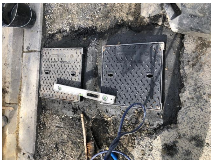
Figure 15 : Mise en place de tampons de regards de purge
