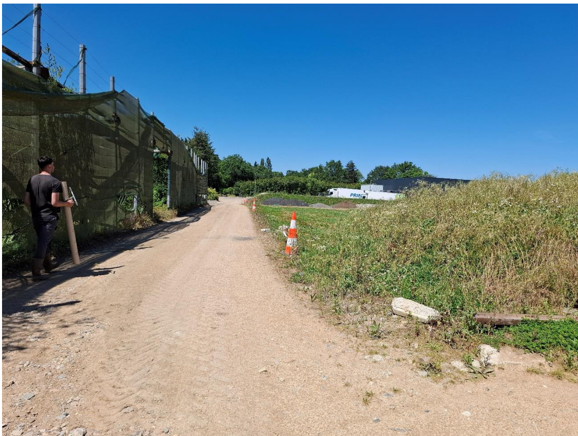
P14 : Vue vers l'ouest depuis le sud-ouest du projet (15/05/2025)
