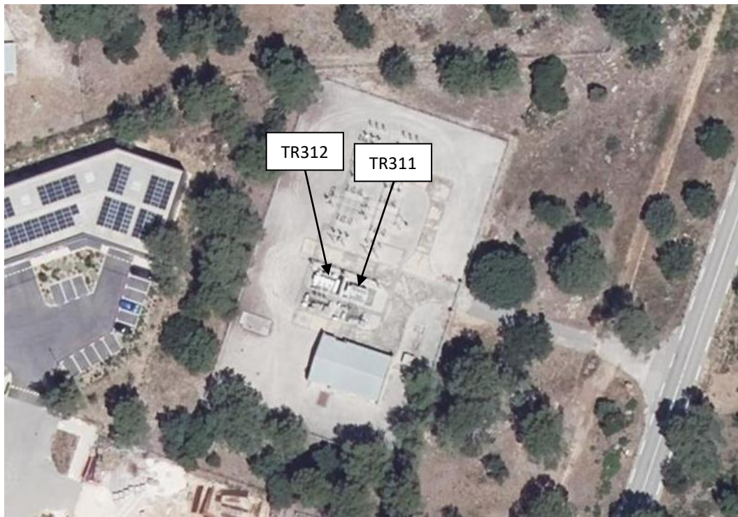
Illustration 8 : Equipements électriques sur le poste source de Signes
