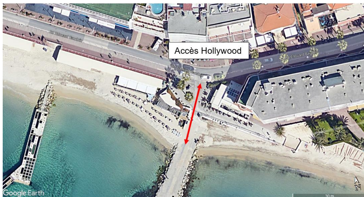
Figure 5 : Accès aux ouvrages depuis le boulevard Edouard Baudoin (Google Earth)
