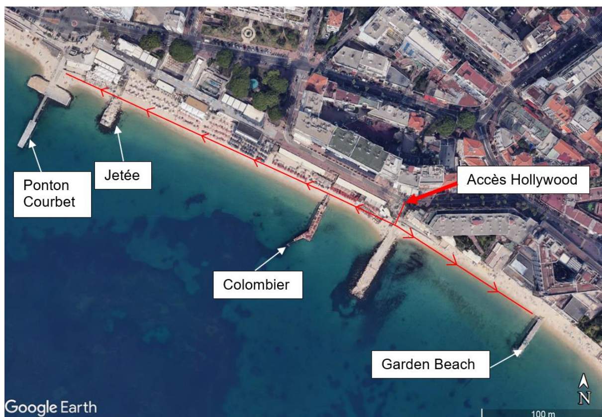
Figure 6 : Accès chantier jusqu'aux ouvrages à supprimer (Google Earth)
