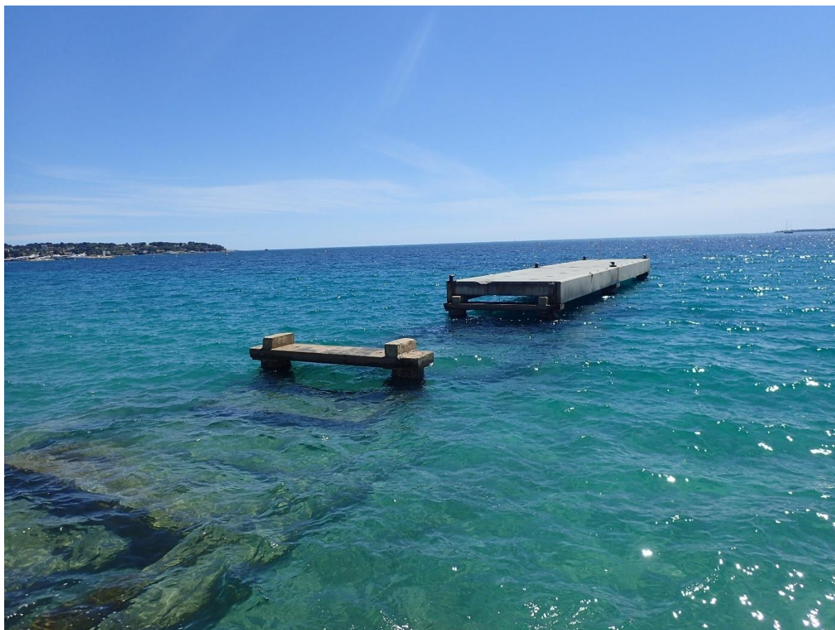
Photo n°3 : Photographie de l'ouvrage effondré (ICTP 2021)
