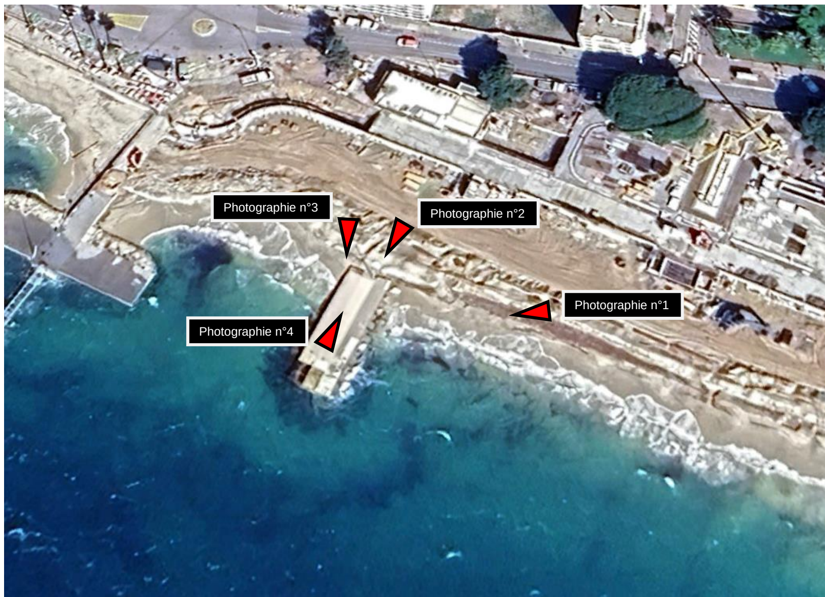
Figure 4 : Localisation des prises des vues au niveau de l'ouvrage « La jetée » (Google Earth)
