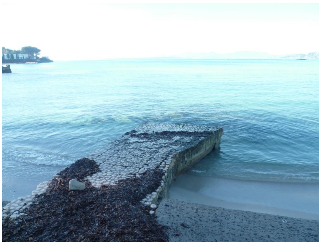
Photo n°8 : Photographie de l'ouvrage de protection de la canalisation d'eau pluviale en béton, perpendiculaire à la plage (ICTP 2023)
