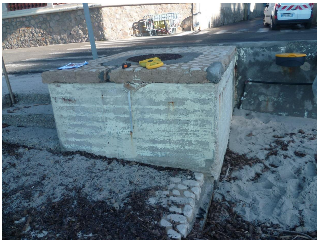
Photo n°8 : Photographie de l'ouvrage de protection de la canalisation d'eau pluviale en béton, perpendiculaire à la plage (ICTP 2023)
