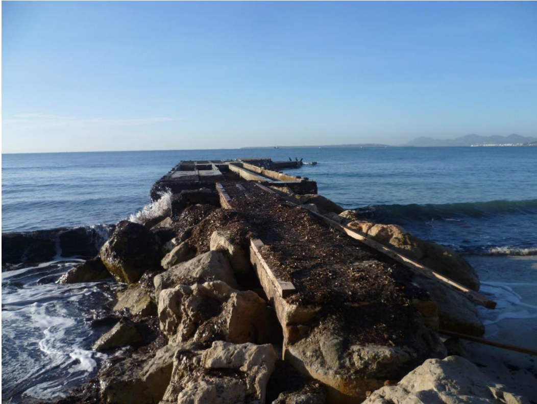
Photo n°2 : Photographie des poutres et des dalles en béton (ICTP 2024)
