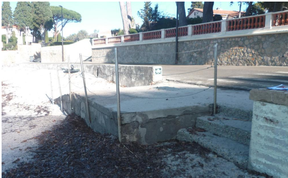
Figure 24. Photographie de la zone d'accès pour les engins de chantier – ICTP 2023
