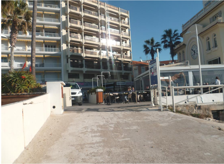
Figure 22. Photographie de la zone d'accès pour les engins de chantier – ICTP 2023
