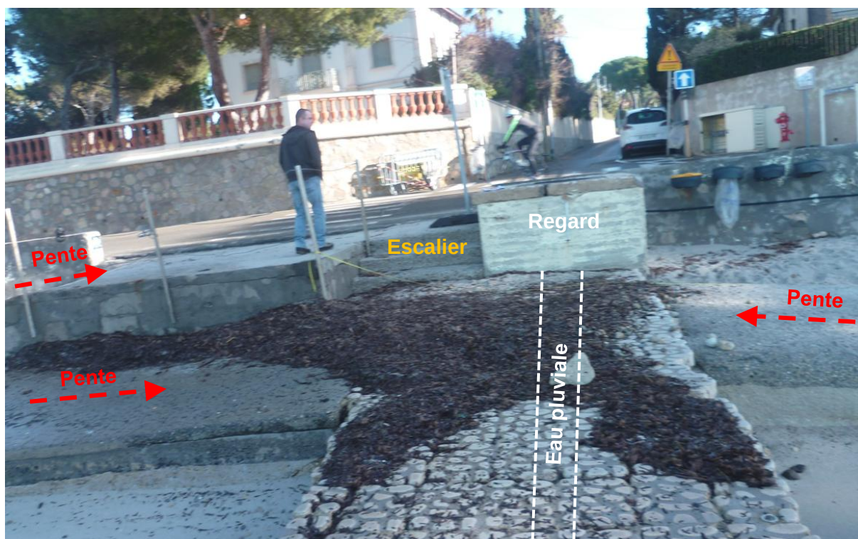
Figure 11. Photographie de l'accès Hollywood : vue depuis la plage – ICTP 2023
