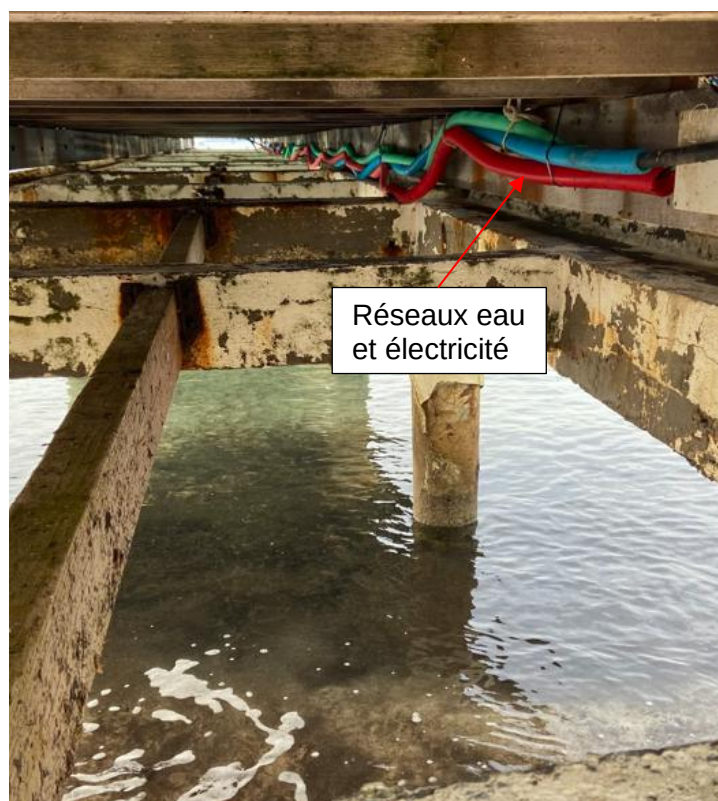
Photo 3 : Ponton « Garden Beach » existant – ICTP 2024
