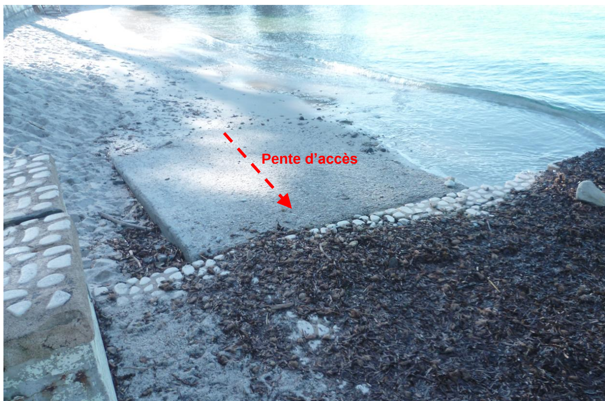
Figure 14. Photographie de l'accès Les Ondes côté Sud – ICTP 2023
