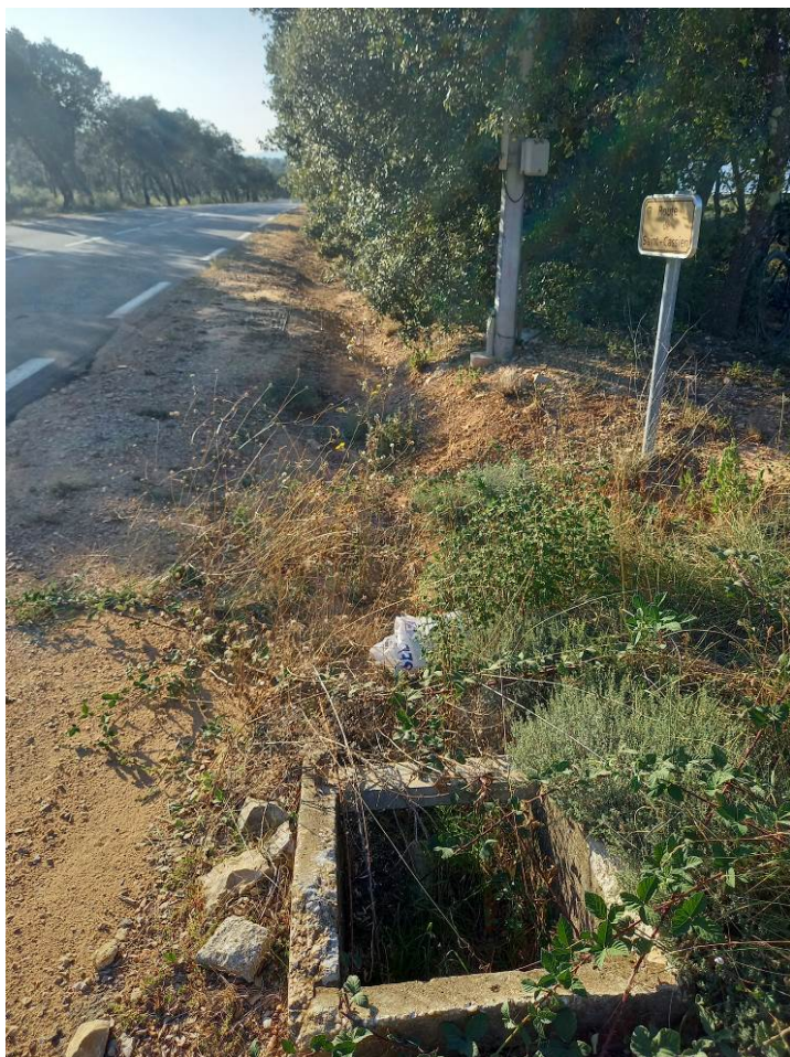
Fossé routier au droit de la centrale photovoltaïque
