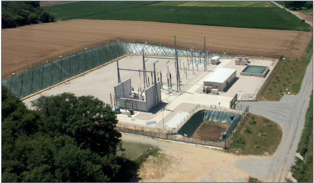
Exemple de poste électrique à l'air libre 225 000/20 000 volts
