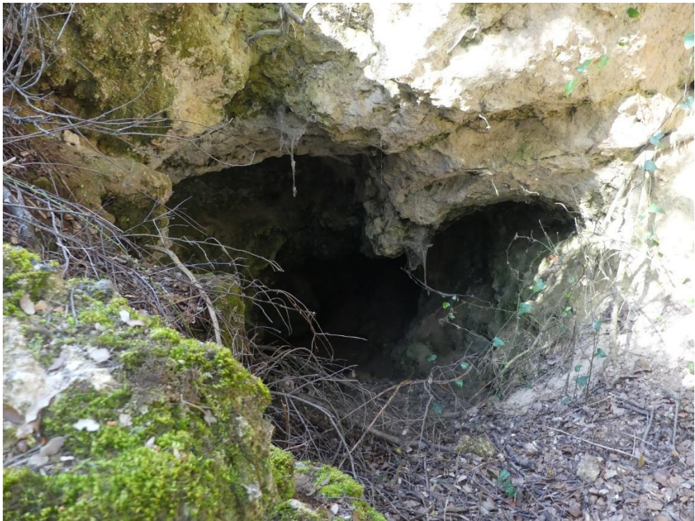
Figure 21 : Cavité souterraine sur site ©EODD, 2025
