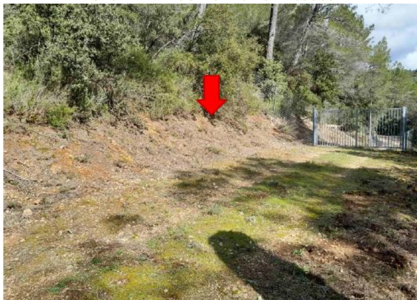
Figure 12. Implantation du sondage de reconnaissance S1 sur le site des Tayettes
