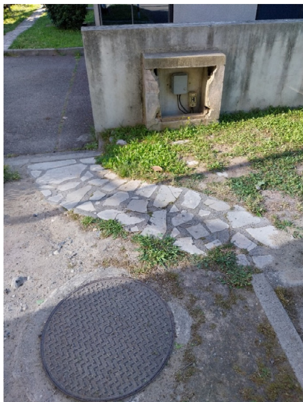
Photographie 7 : Regard réseaux d'eaux EP
