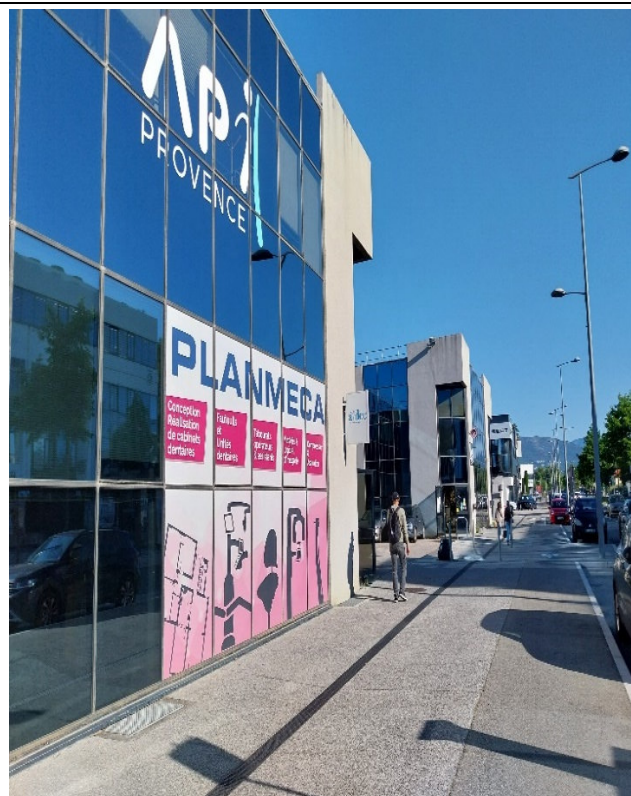
Photographie 2 : Façade Est du bâtiment
