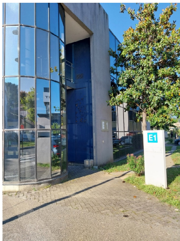
Photographie 8 : Entrée des bureaux au Nord-Ouest du site
