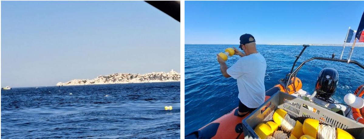
Figure 5. Installation des balises le long du tracé du câble (source : setec énergie environnement, 2025)
