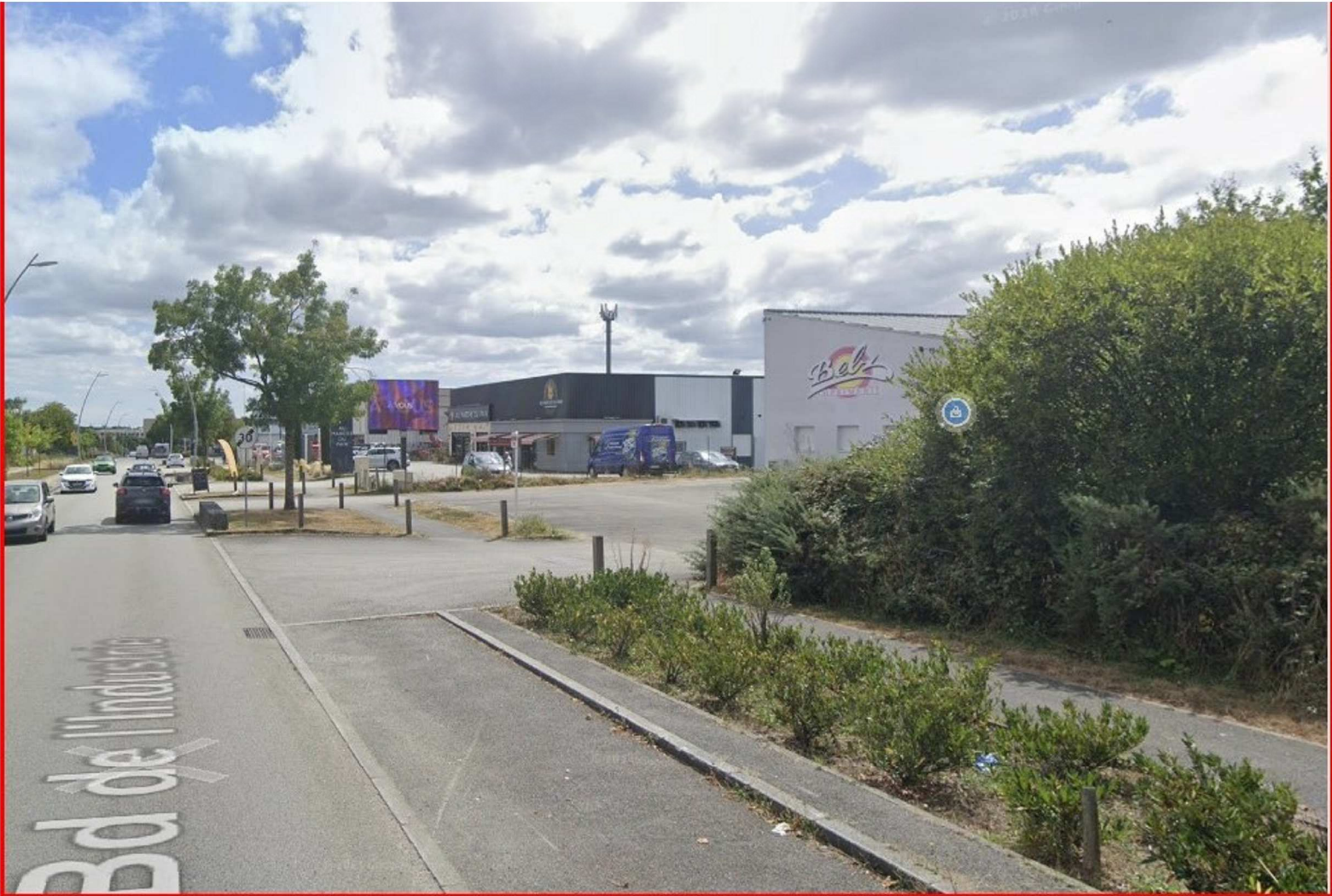
02 vue lointaine depuis Nord-Est
