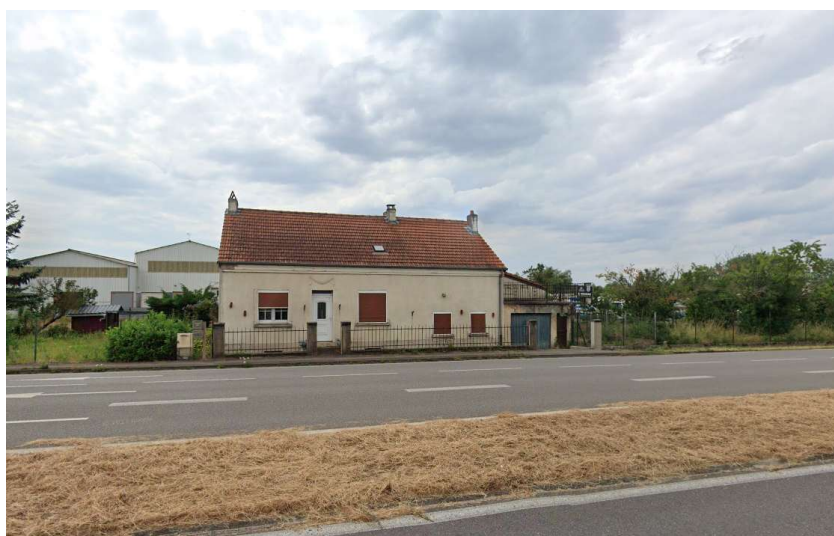
Vue de la construction existante sur la parcelle 143 section 2. (Source : Google)
