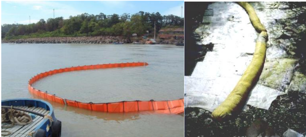
Figure 5. Installation d'un barrage flottant / barrage absorbant ( http://www.flexitankchina.fr ) / ( cedre.fr )
