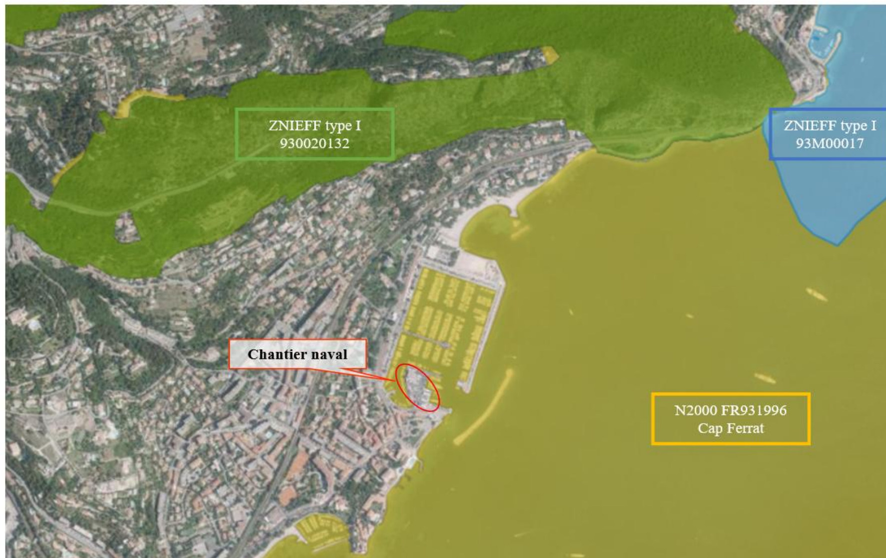
Figure 3. Localisation du chantier naval par rapport aux espaces protégés (Géoportail)
