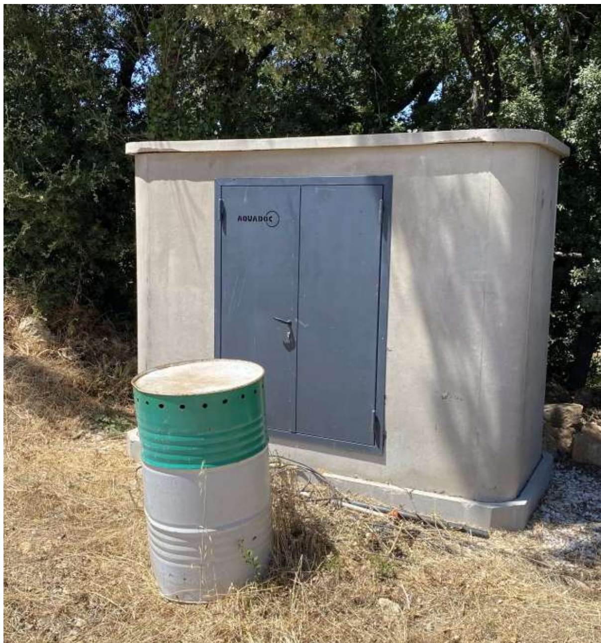
Tête du forage fermée et local (Hangar)
