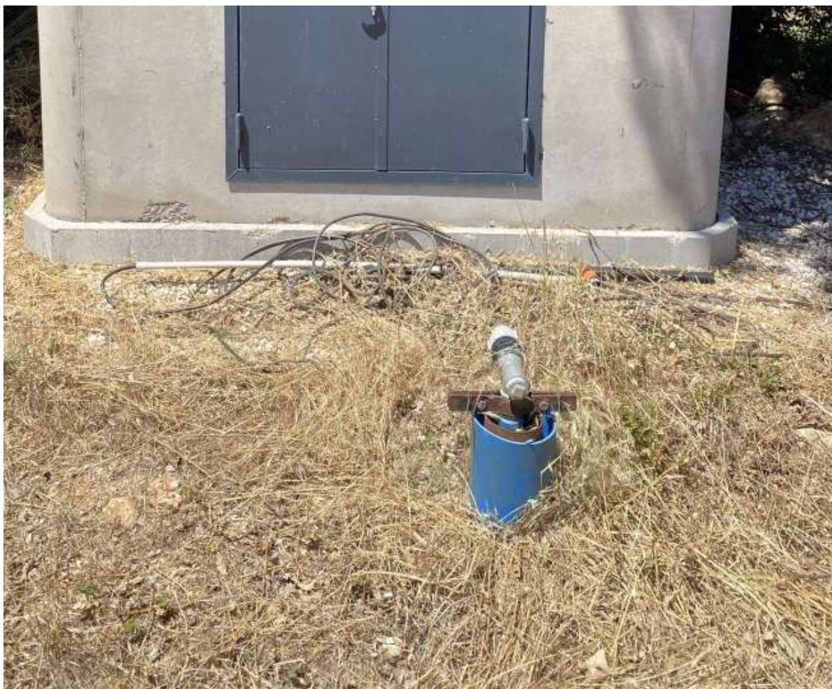
Tête du forage ouverte (Hangar)
