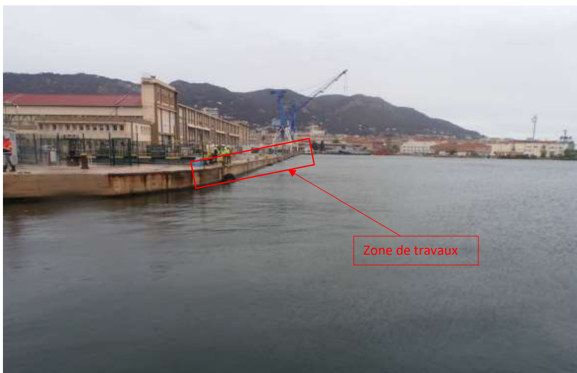
Vue de la partie Sud du quai
