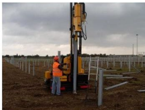
Figure 6 : Exemples de structures fixes et fondations par la méthode des pieux battus
