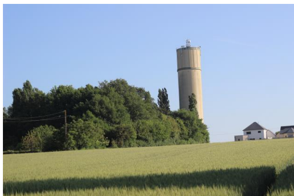
Figure 15 : aperçu du tronçon GA depuis le point D
