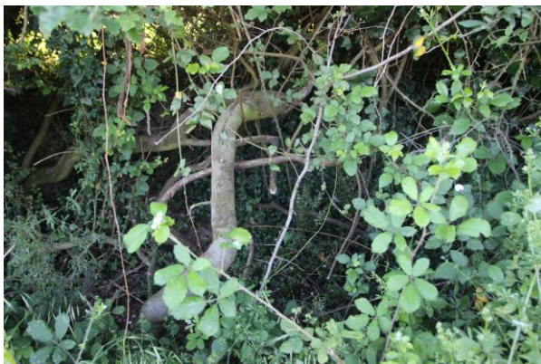
Figure 24 : trouée dans la haie CD vers la parcelle 0980, avec épaisses branches cassées
