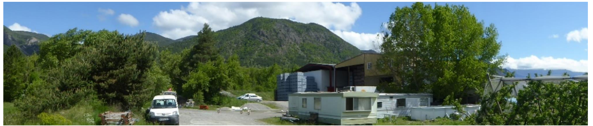
Photo 21 – Limite Nord-ouest occupée par des entrepôts, les vues vers le site sont vaines.
